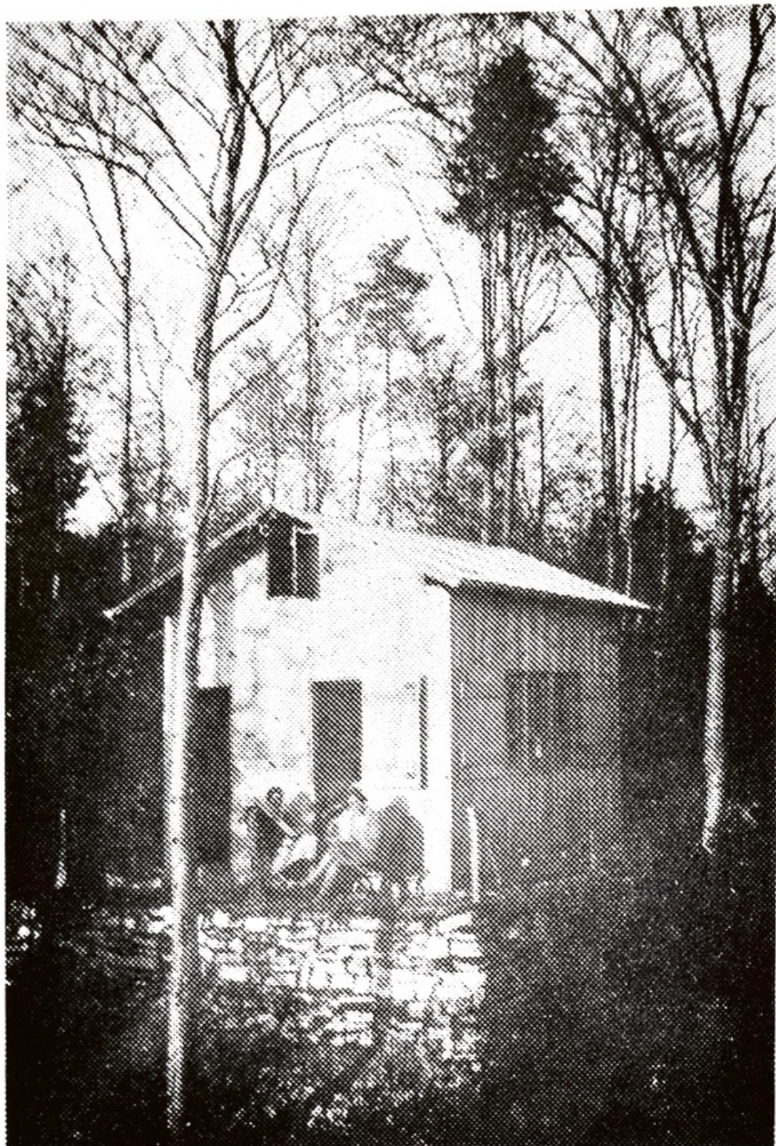
Unsere Hütte wie sie 1929 gebaut wurde
